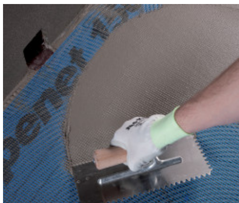
Laying Mapelastic on Mapenet 150
